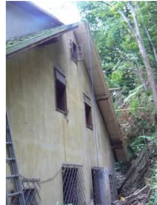
14. September 2009: neue Dachschalung!
