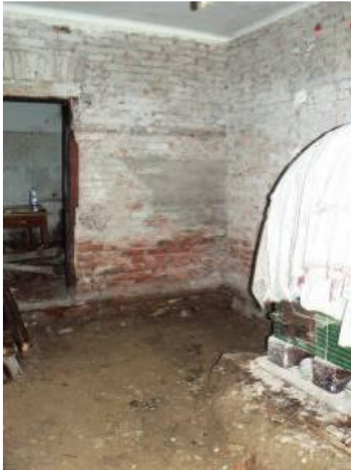
18. Oktober 2009: das "Extrazimmer" ist von Verputz befreit und der Boden ist jetzt 40cm tiefer ;)
