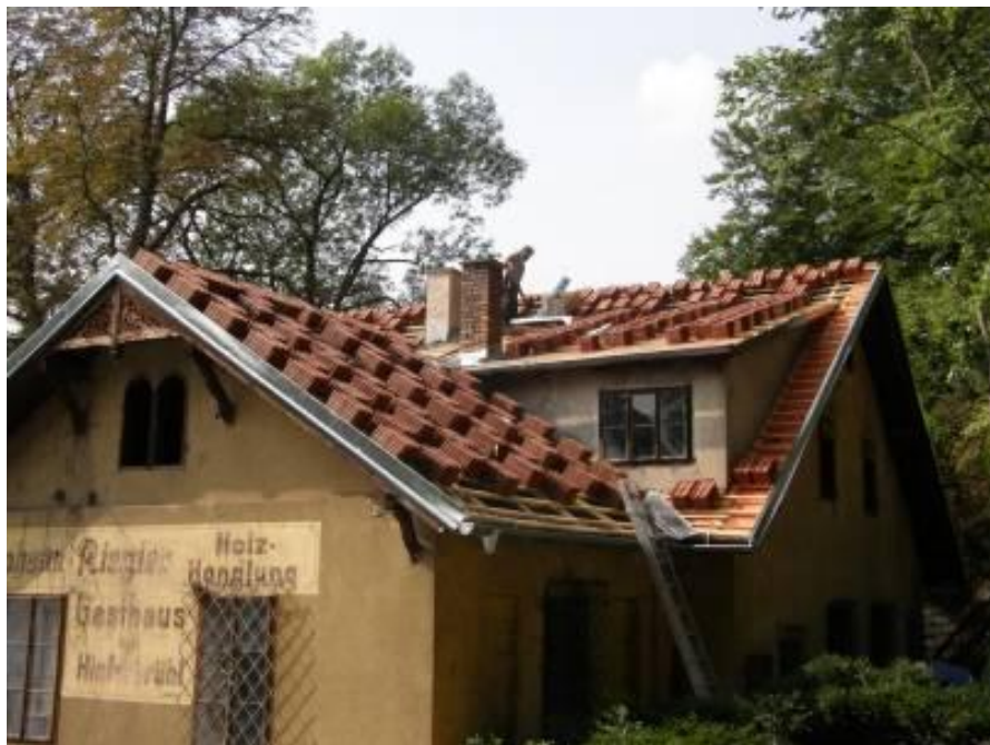
24. September 2009: die Dachziegel wurden geliefert
