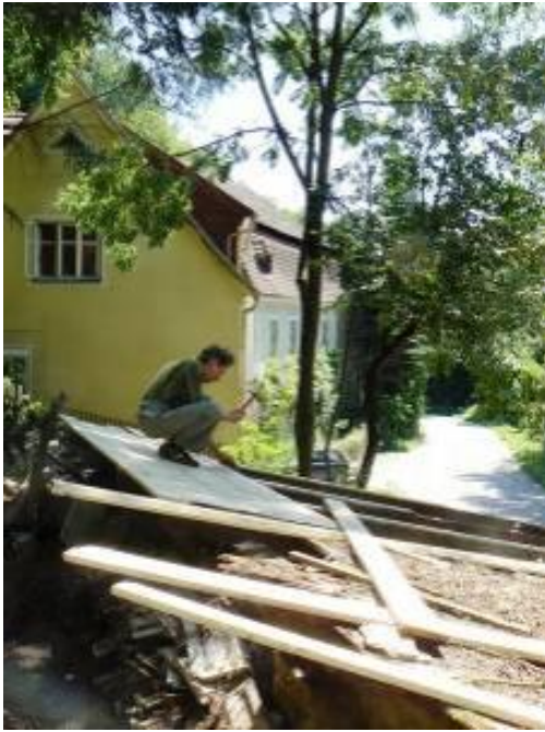
26. Juli 2009: Martin bei der Schalung des Kegelbahn-Daches
