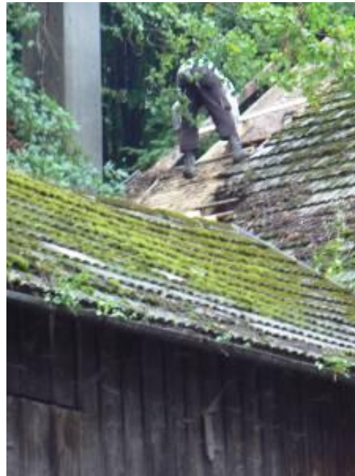
14. September 2009: die Dachdecker sind da - die mind. 60 Jahre alten Betonziegel kommen runter!
