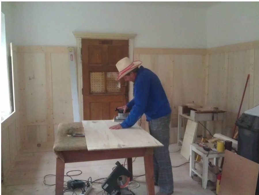
Mai 2013: Martin arbeitet an der Lamperie der kleinen Gaststube
