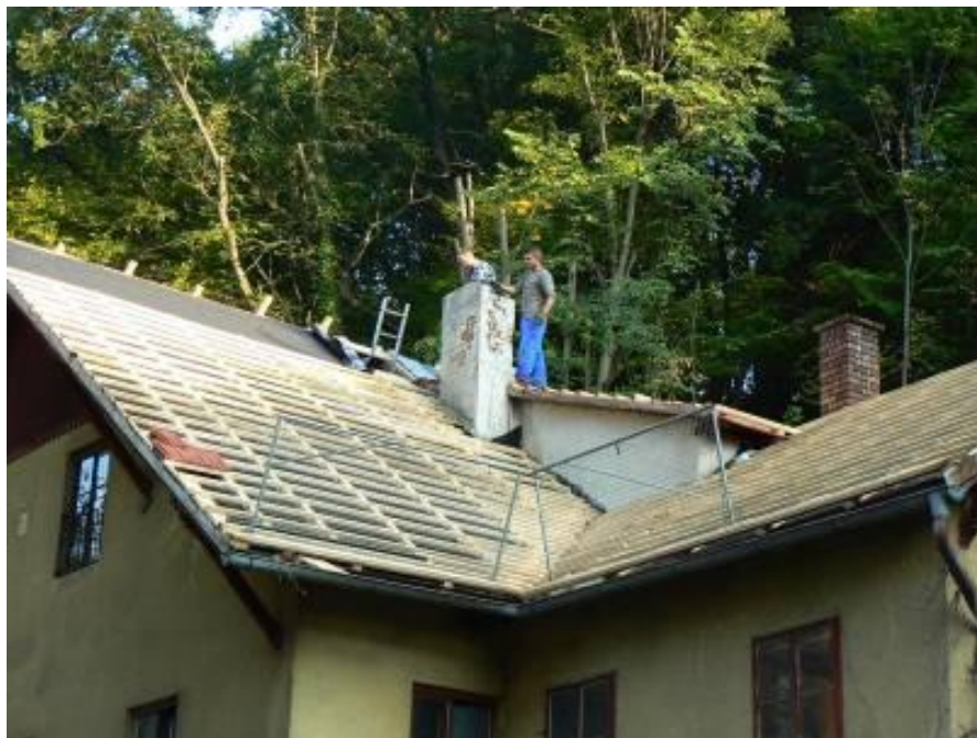
...mit neu aufgemauerten Kamin
