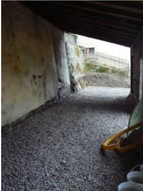
Karwoche 2010 – Kegelbahn drainagiert und geschottert
