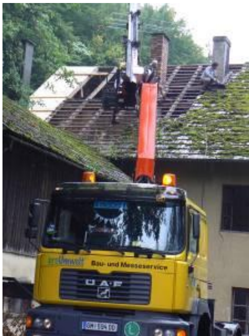
jetzt kommt der Rest auch runter!
