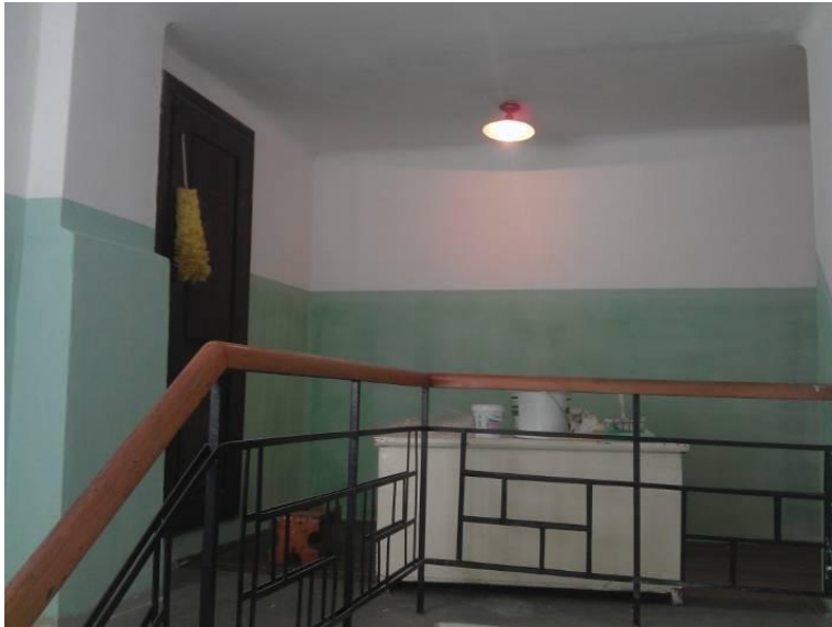
29. September 2012: Stiegenhaus im 2. Stock (fast) fertig
