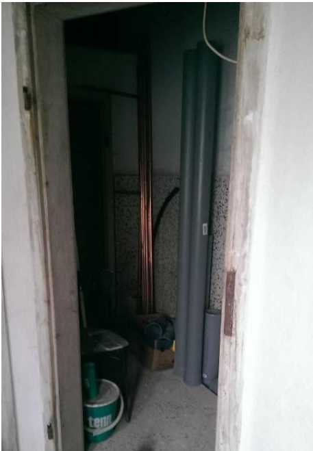
April 2014: Beginn der Installateur-Arbeiten (Wasserleitung etc)
