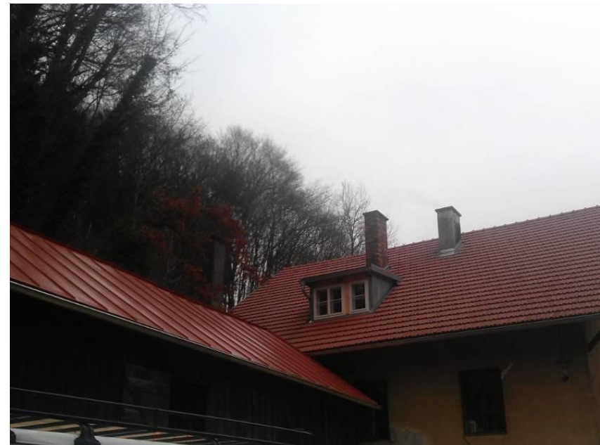
November 2012: Schupfendach ist auch fertig – rechtzeitig vor dem Winter!
