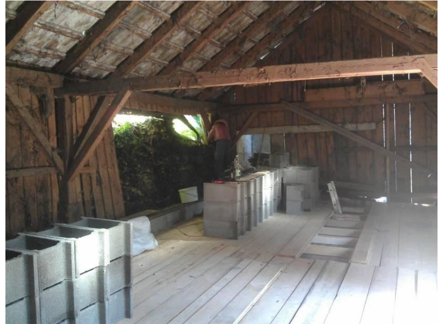
5. August 2012: einWandfreies Gebäude - künftige Werkstatt (Schuppendachboden) bekommt Hangabwehrmauer
