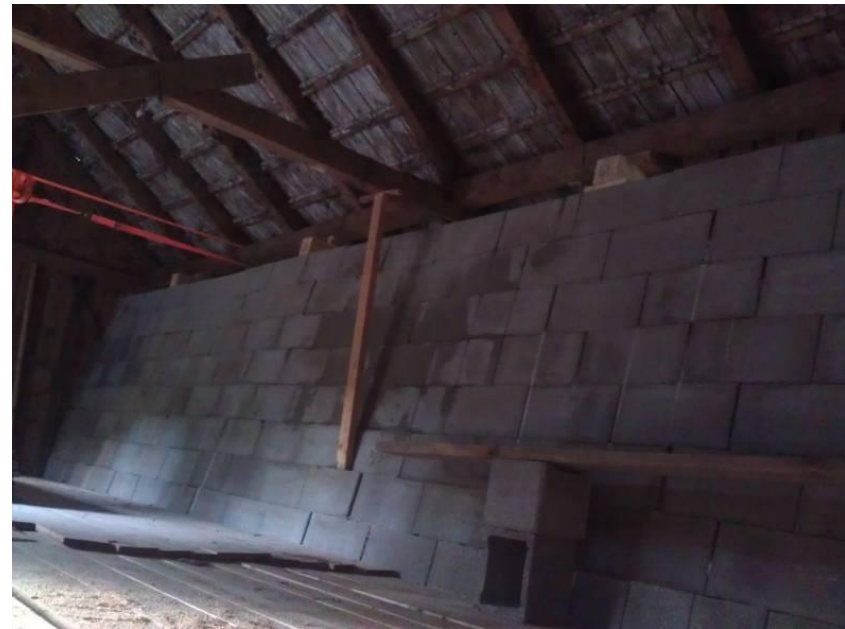
23. August 2012: Fertig! Ca 350 Betonsteine geschichtet und ausbetoniert.
