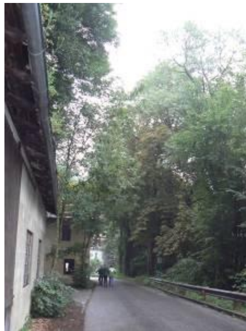
5. August 2009: die Bäume über der Straße gehören auch zu uns - die müssen fallen, damit das Haus durch Licht und Luft weiter trocknen kann (auf dem Dach wächst kiloweise Moos)
