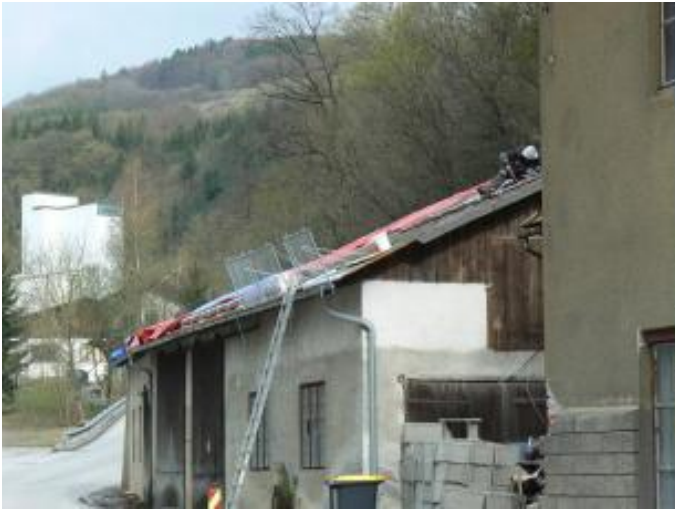
März/April 2012: Dachdecker am Werk!
