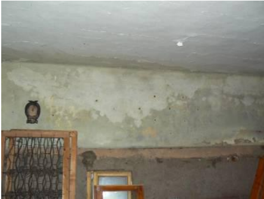
11. Juli 2009: die Trockungsmaßnahmen beginnen Wirkung zu zeigen! die hellen Flecken oben sind schon trocknendes Mauerwerk!
