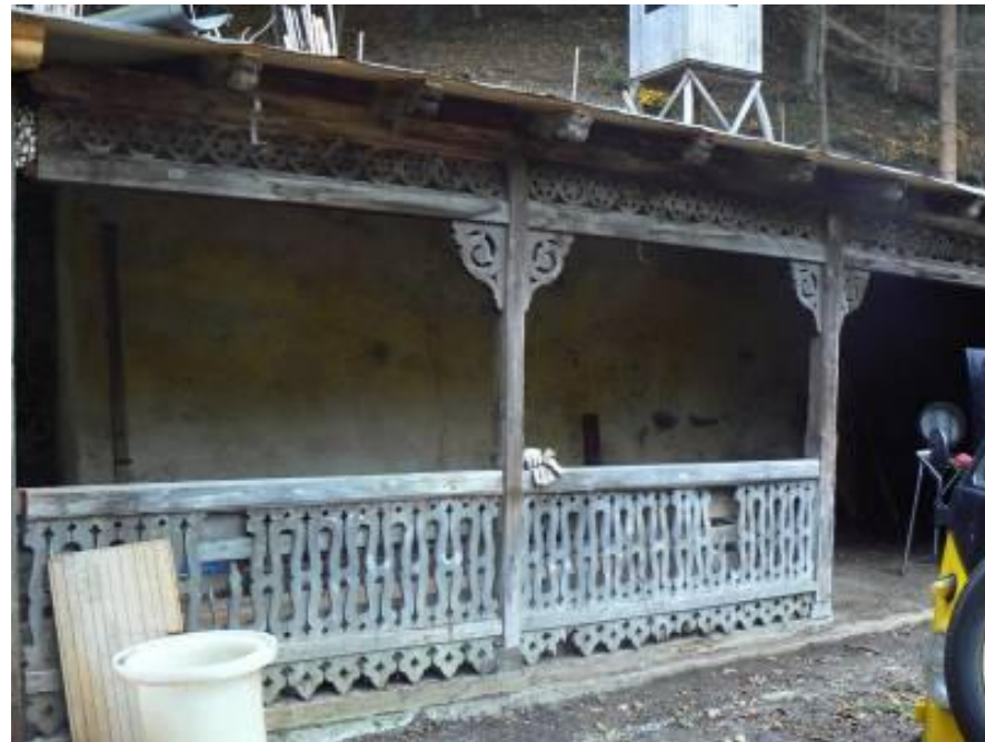
1. November 2009: Die Kegelbahn beginnt endlich auszusehen wie eine solche (sie muss ja schließlich bis Juni fertig und bespielbar sein!)
