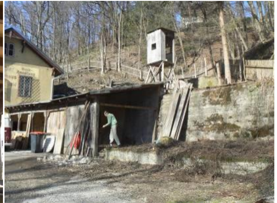
5. März 2010 – nach dem langen Winter: endlich – Beginn mit der Kegelbahn-Restaurierung bzw. Neubau
