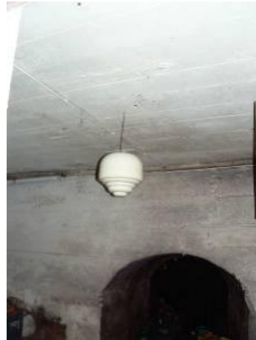
11. Juli 2009: die Trockungsmaßnahmen beginnen Wirkung zu zeigen! die hellen Flecken oben sind schon trocknendes Mauerwerk!
